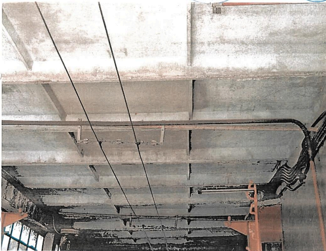
Invelitoare hala spalatorie
