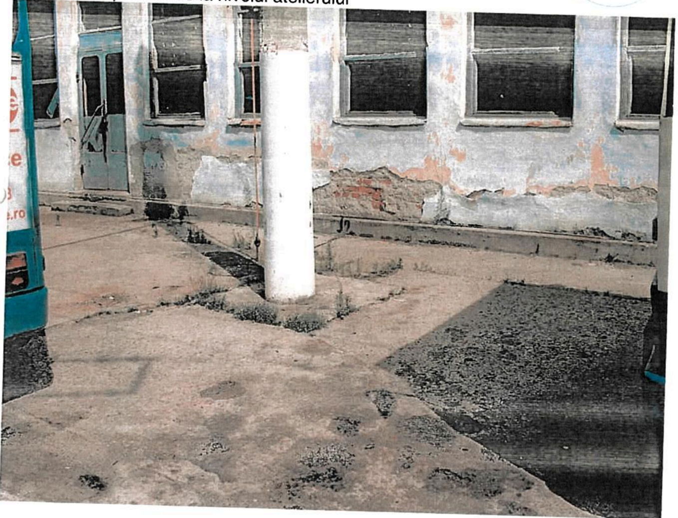
Tencuiala expulzata de la nivelul atelierului
